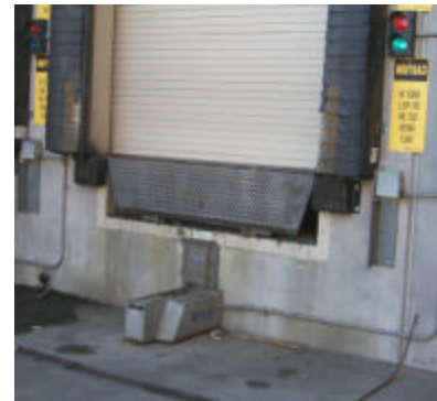
Sujetadores vehiculares montados en la zona de carga se anclan a una barra debajo de vehículo.
